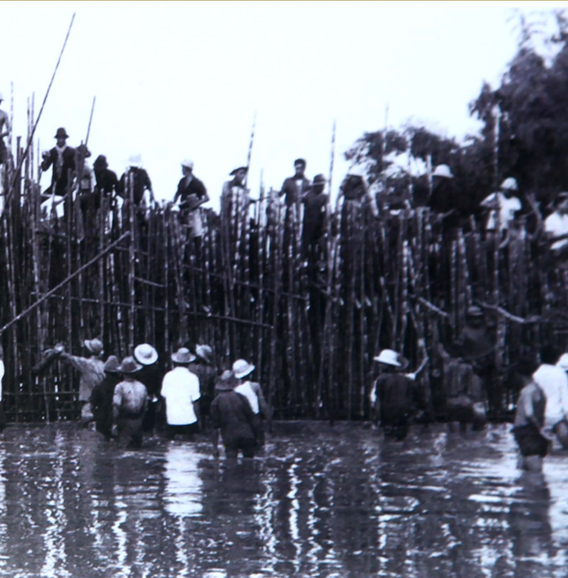
ชาวบ้านผู้ใช้น้ำร่วมแรงร่วมใจกัน 'ตีฝาย' หรือซ่อมแซมฝายพญาคำ ซึ่งเป็นประเพณีที่สืบทอดกันมาในเดือนมีนาคมของทุกปี ภาพนี้ถ่ายเมื่อปี พ.ศ. 2498 ถ่ายโดยวิจิตร ไชยวรรณ
